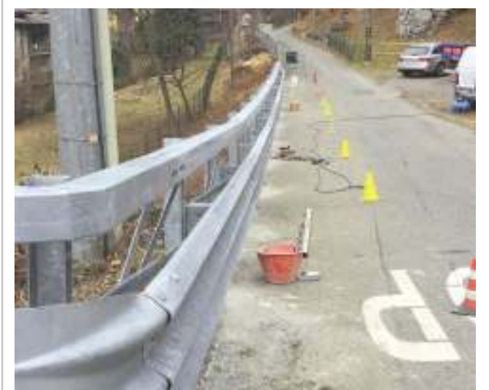
I guard-rail di frazione Lorazzo inferiore
