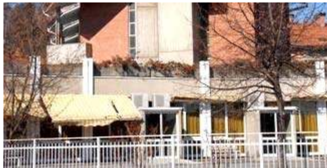
La casa di riposo Comotto di Vigliano Biellese
