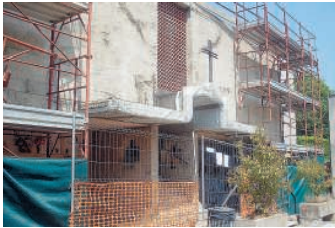
La parte inagibile del cimitero di Ronco Biellese
