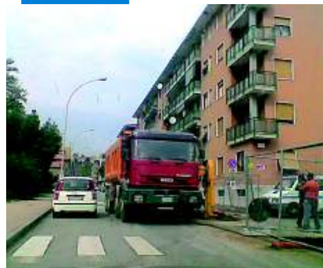
UN CANTIERE CHE FA DISCUTERE Continuano i lavori per la realizzazione della rete di distribuzione del teleriscaldamento. In queste settimane le scavatrici e i camion sono al lavoro in via Delleani, per realizzare il raccordo tra il tratto sud da viale Macallè, e quello di via Tripoli, entrambi già completati. Ma in questa via il cantiere sta sollevando alcune perplessità tra gli abitanti della zona. Che segnalano come la "coabitazione" tra i mezzi di lavoro e la circolazione (che non è stata interrotta) sia a volte rischiosa. Specialmente quando, come nella foto, le scavatrici caricano i camion mentre transitano le auto.
