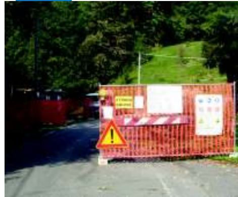
LA STRADA RIAPRE A FINE NOVEMBRE E' chiusa al traffico, da lunedì 28 settembre, la provinciale 504 Pollone-Cossila San Giovanni, dal bivio Vandorno-Cossila San Grato, fino all'uscita sulla via per Oropa per lavori del Cordar sull'acquedotto. «La chiusura con accesso consentito ai residenti» spiega Fabio Della Villa del Cordar «si è resa necessaria per poter collegare all'acquedotto le case delle famiglie residenti nella frazione Cogna che finora hanno sempre utilizzato una sorgente privata della cui acqua lamentavano soprattutto la scarsità. Contiamo di finire i lavori entro il 27 novembre».
