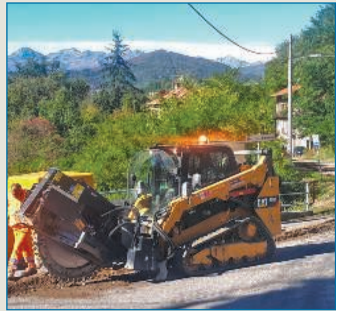
La mappa dal satellite della fibra posata a Casapinta. A sinistra la sostituzione dei pali di sostegno deteriorati. Sotto i lavori nelle strade del paese e l'escavatore usato per tagliare le strade
