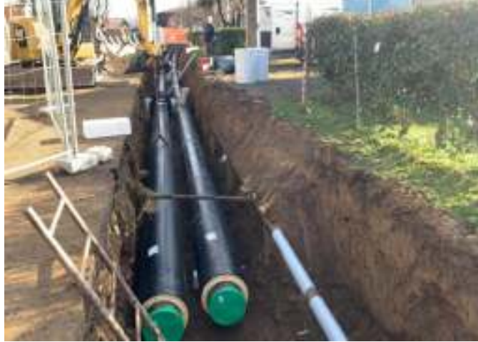
LA POSA di alcuni tubi del teleriscaldamento (foto Paiato)
