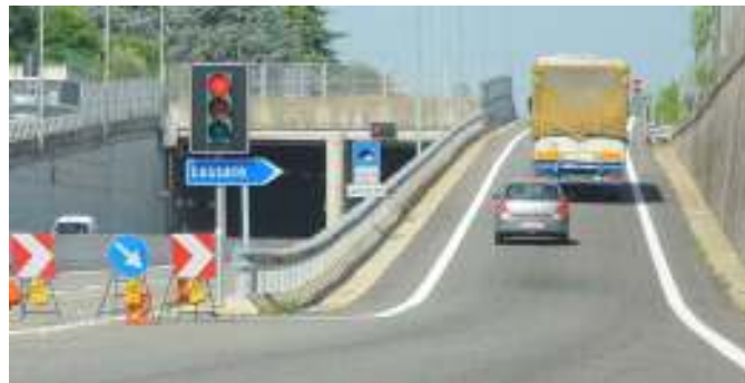
La rampa in corso San Maurizio per via Cottolengo sarà chiusa
