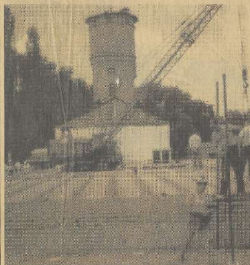
Un'immagine del cantiere di Rossosch dove gli alpini stanno costruendo un asilo
